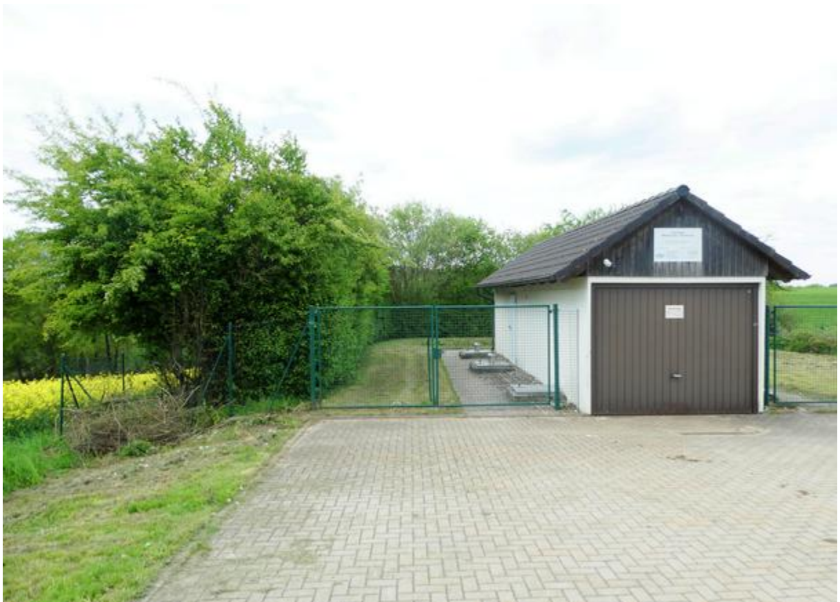
Abbildung 6: Bestandsgebäude kommunale Kläranlage Walpenreuth.
