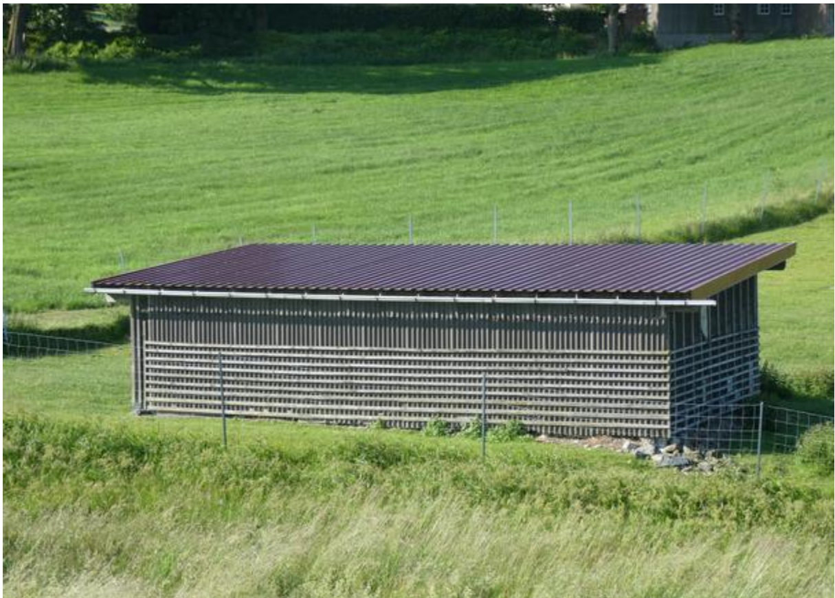
Abbildung 10: Landwirtschaftliches Bestandsgebäude am Südwestrand der Planungsfläche.
