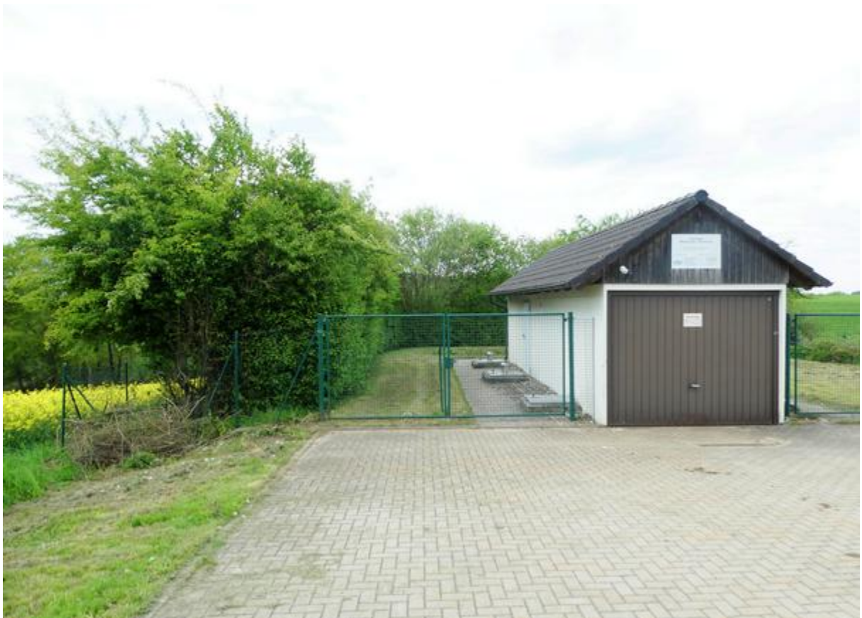
Abbildung 6: Bestandsgebäude kommunale Kläranlage Walpenreuth.
