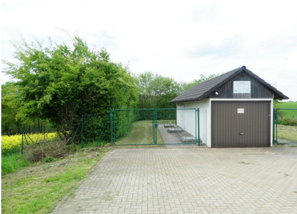
Abbildung 6: Bestandsgebäude kommunale Kläranlage Walpenreuth.
